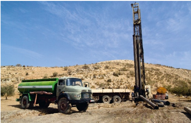
Grundwasserbohrung in Jordanien. Im Gegensatz zu Deutschland ist in vielen Ländern die Trinkwasserversorgung der Bevölkerung angespannt. In Jordanien sind beispielsweise aufwendige Bohrungen notwendig, um Grundwasser aus großen Tiefen zu gewinnen.
