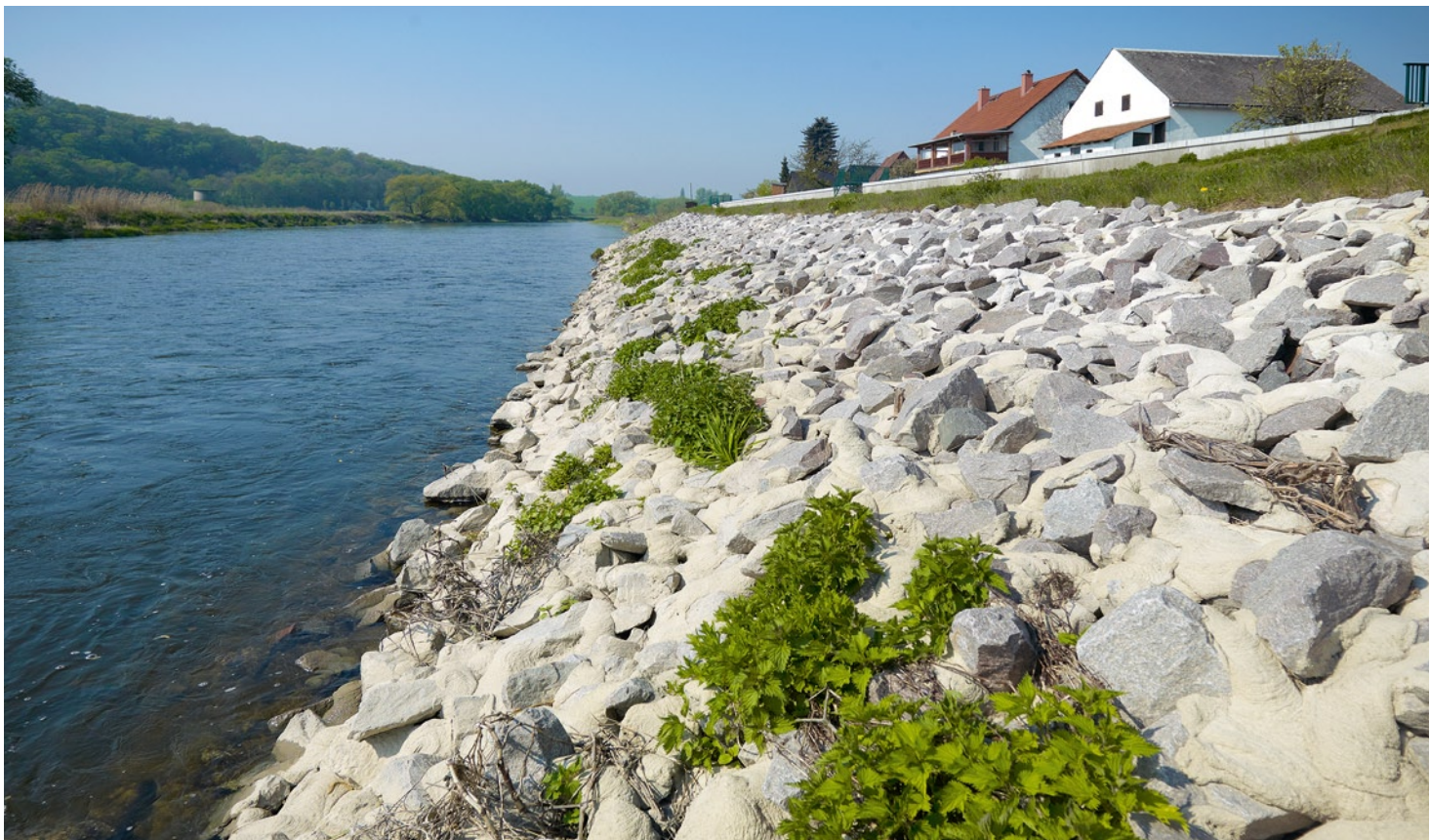
Uferbefestigungen an der Mulde in Sachsen. Zwar sind die chemischen Belastungen von Flüssen und Seen in Deutschland erheblich zurückgegangen, trotzdem bleibt der ökologische Zustand der meisten Gewässer unbefriedigend. Häufig sind wasserbauliche Maßnahmen wie Ausbau für die Schifffahrt oder Hochwasserschutz dafür verantwortlich.
