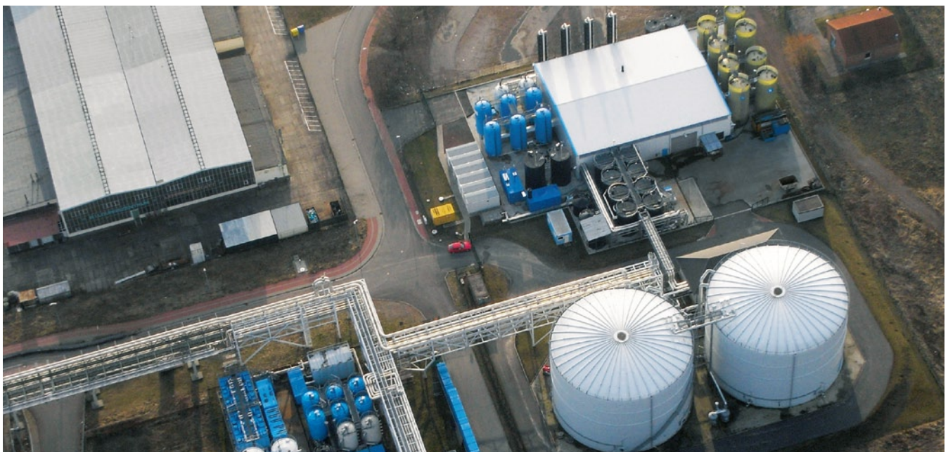
In der Grundwasserreinigungsanlage am Standort Bitterfeld, die bis zu 200 Kubikmeter hochkontaminiertes Grundwassers pro Stunde reinigt, führte das Stripping-Verfahren zu Problemen mit den im Grundwasser enthaltenen Schwefelverbindungen. In einer Container-basierten Pilotanlage (blaue Container auf dem Foto) testeten UFZ-Wissenschaftler erfolgreich ein neues Verfahren zur Entschwefelung dieser Strippgase. Foto: Dr. Robert Köhler/UFZ
